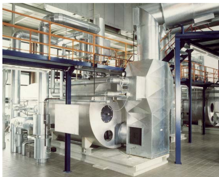
Obr. 1: Parní kotel UNIVERSAL s ekonomizérem ECO 1 pro samostatné umístění s výkonem 1 – 28 t/h páry
