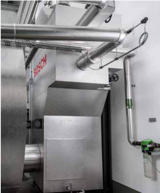
Abbildung 2: Dampfkessel UNIVERSAL mit ECO 1 Stand-Alone für 1–28 t/h Dampfleistung
