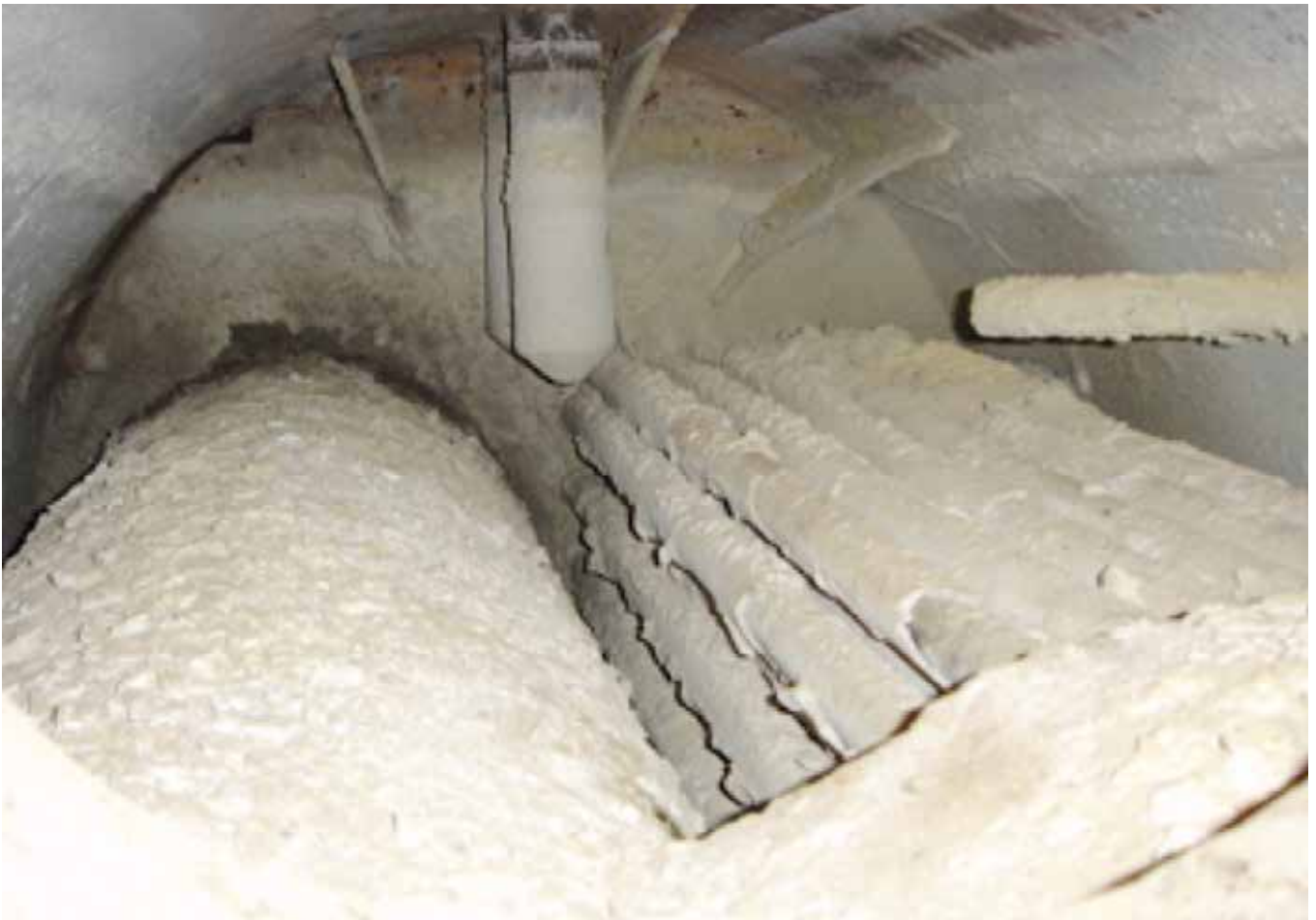
Bild 1: Folgen einer mangelhaften Härteüberwachung
