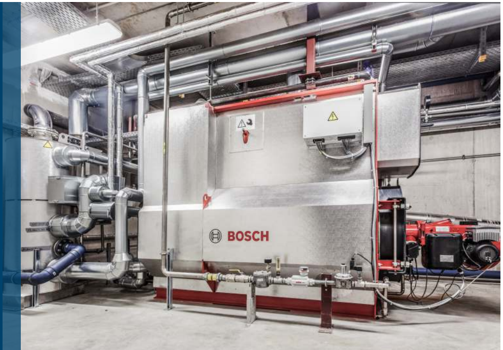
Die kompakte Bauweise des Kesseltyps U-MB überzeugte.
