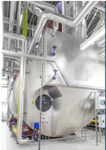
Effektive Abwärmenutzung mit integriertem Economiser.
