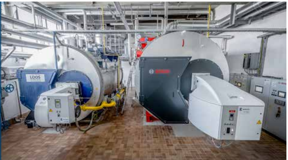
Effizient und flexibel einsetzbar: Die beiden Dampfkessel UL-S bei der Molkerei NÖM.
