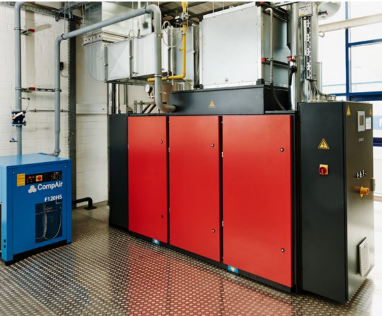
Druckluft-Wärme-Kraftwerk von Bosch
