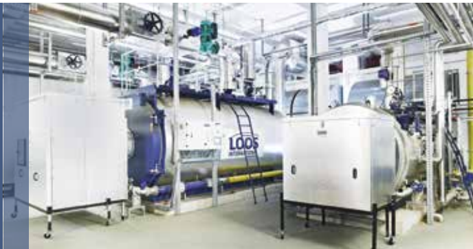
Effiziente Wärme- und Dampfversorgung: Die Heizkessel UT-L sowie ein Dampfkessel UL-S.
