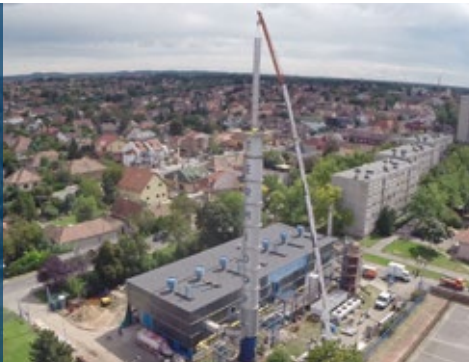
Heizkraftwerk Dunakeszi Közüzemi Kft. während der Umbauphase
