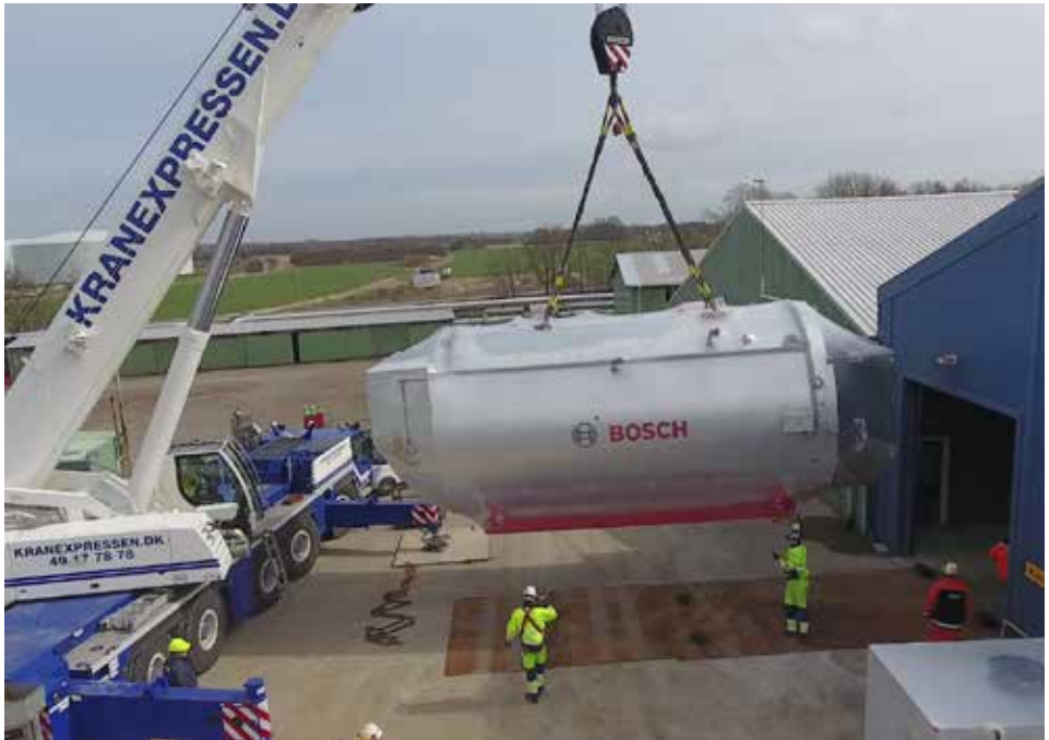
Bilder: Einbringung, Installation und Inbetriebnahme der UL-SX Dampfkessel.
