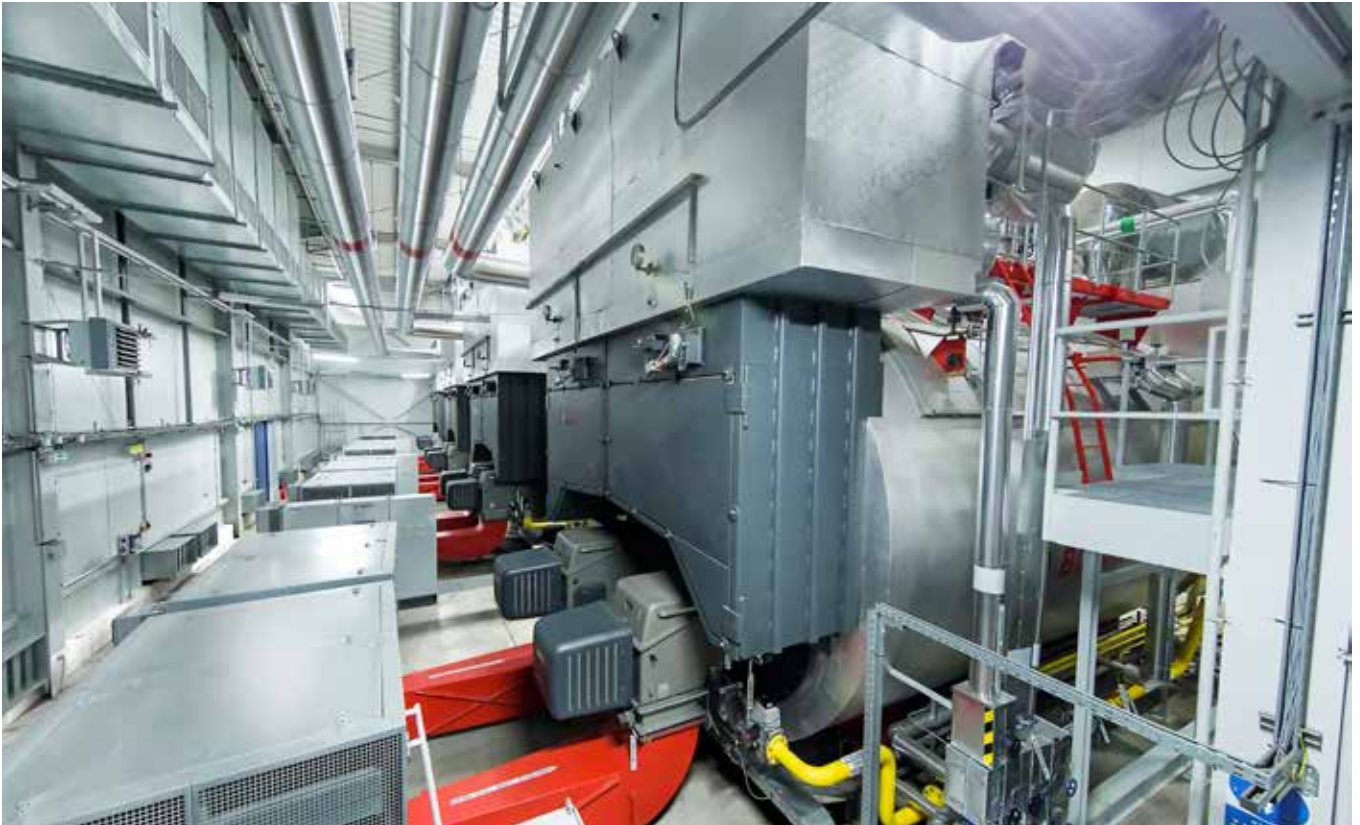
Abbildung: Einsatzbeispiel – vier Zweiflammrohrkessel mit Überhitzermodulen
