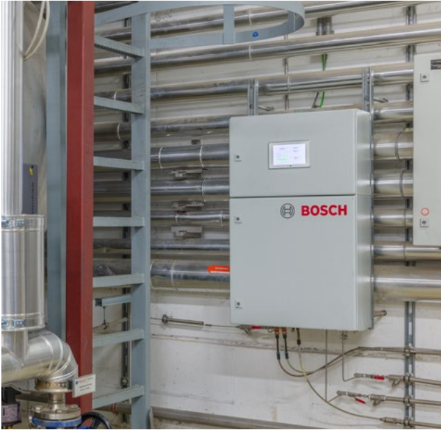
Vollautomatisch und zuverlässig: Das platzsparende Modul prüft kontinuierlich die relevanten Wasserparameter.
