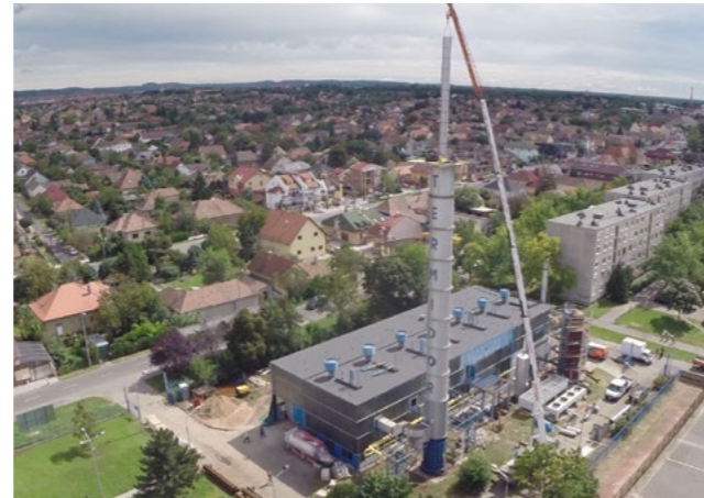
Heizkraftwerk Dunakeszi Kőüzemi Kft. während der Umbauphase.
