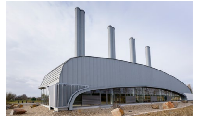
Hochmodern und innovativ: Das Heizkraftwerk Pieter Wiersma in Lent.
