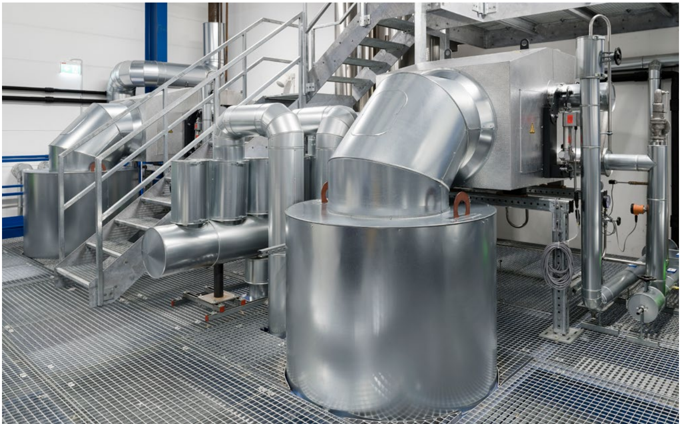
Brennwertwärmetauscher: Brauchwasser mit Kondensationswärme kosteneffizient vorwärmen.
