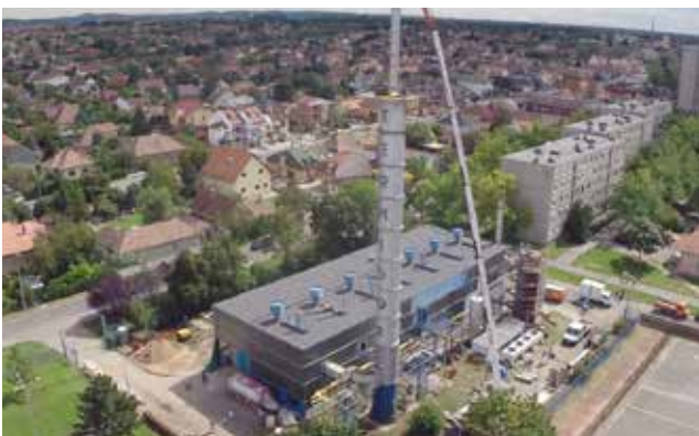
Heizkraftwerk Dunakeszi Közüzemi Kft. während der Umbauphase.
