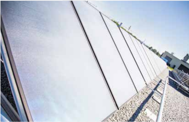
Die Solarthermieanlage unterstützt die Speiswassererwärmung mit kostenloser Sonnenenergie.
