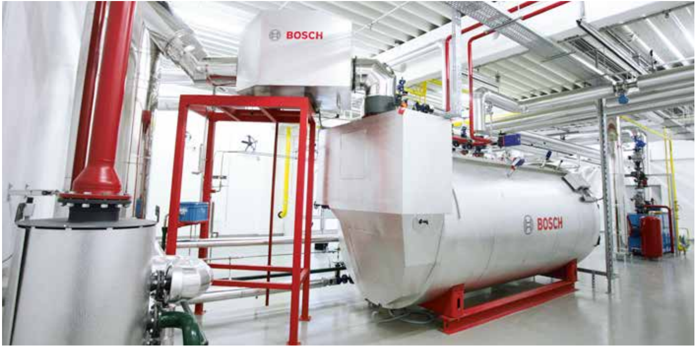
Economiser und Brennwertwärmetauscher zur Abgaswärme-Rückgewinnung.
