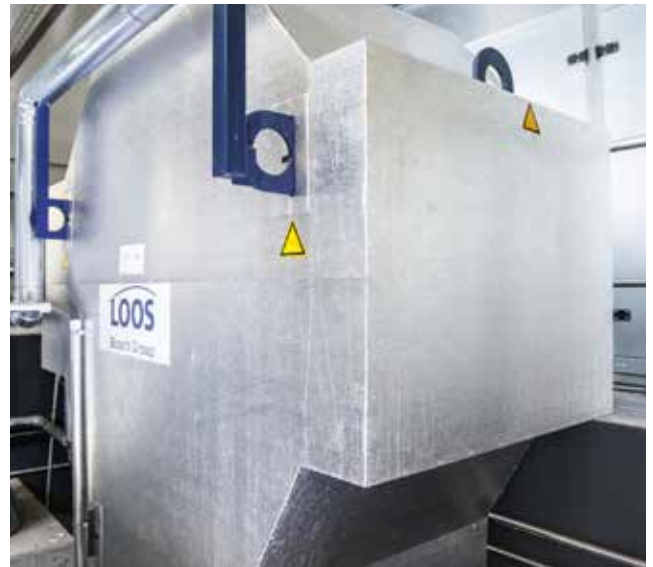
Separater Abgaswärmetauscher dem vierten Rauchrohrzug nachgeschaltet für höchste Wirtschaftlichkeit.
