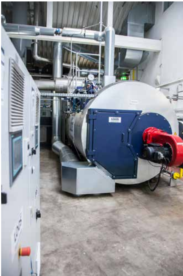
Effizienz im höchsten Maßstab: Die innovative Kesselanlage mit zusätzlichem vierten Rauchrohrzug und Eigenfeuerung.
