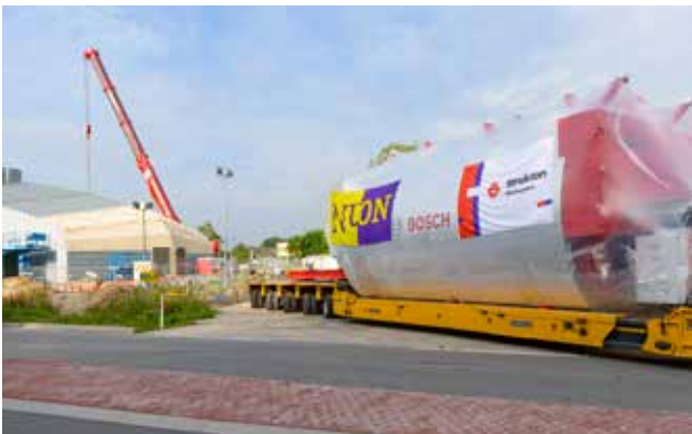
Jeweils 68 Tonnen auf dem Tieflader bzw. am Kran: Anlieferung und Einbringung der Bosch-Heißwasserkessel.
