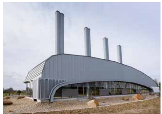
Hochmodern und innovativ: Das Heizkraftwerk Pieter Wiersma in Lent.
