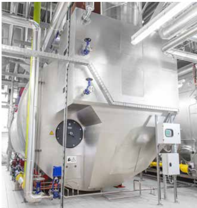
Effektive Abwärmennutzung mit integriertem Economiser und Abgaswärmetauscher.
