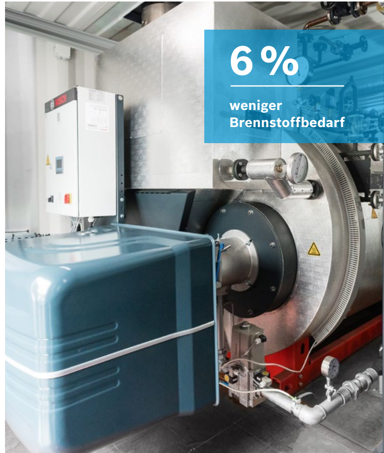
Kompakte Einheit mit Economiser, Steuerung und Brenner.
