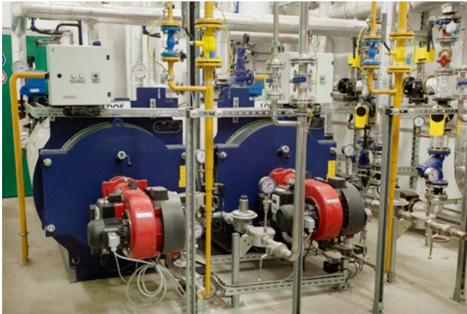
Die zwei kompakten Heizkessel UT-L erzeugen Wärme für den Betrieb der Fermenter.
