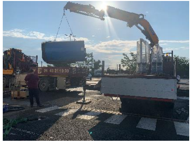
Démontage et évacuation
