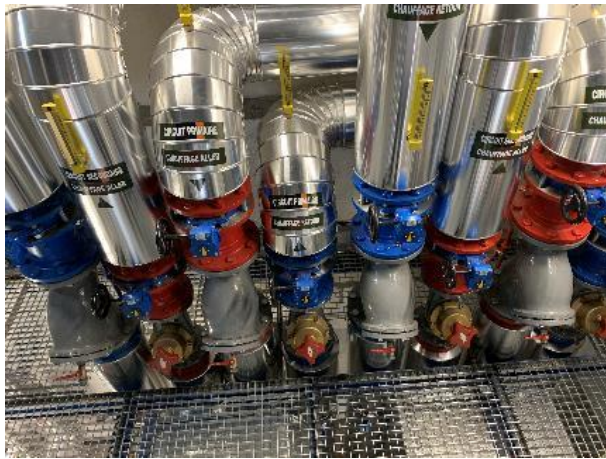
Raccordement réseaux hydrauliques
