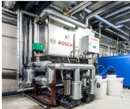
Dégazage de l'eau d'alimentation
