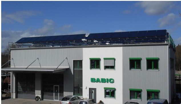
Photos : Aschoff Solar GmbH
